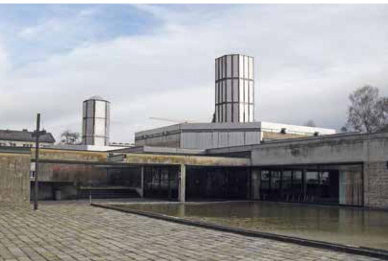
Abb. 5: Gartenstadt Puchenu, wie Abb. 4, Zustand 2015, Tamboure mit Kunststoffklebebandern, unsachgemäße Behebung von Bauschäden, gesamte Anlage baulich schlecht betreut, verändert – ein Fall für die Denkmalpflege
