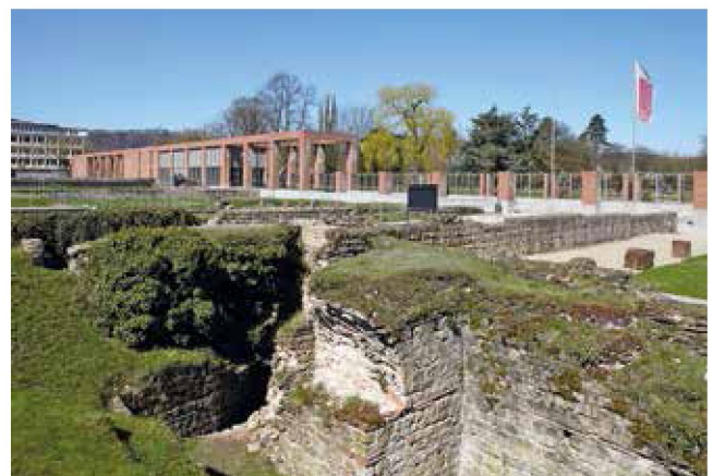
Abb. 6: Das von O. M. Ungers 2007 erbaute Entreegebäude der Kaiserthermen
