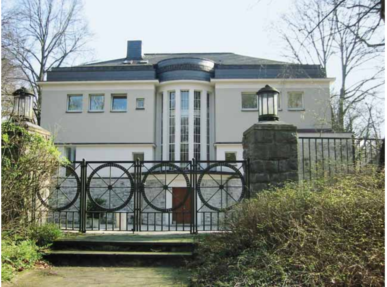
6 Peter Behrens, Villa Cuno, Hagen, 1909/10 (Zustand 2005)
