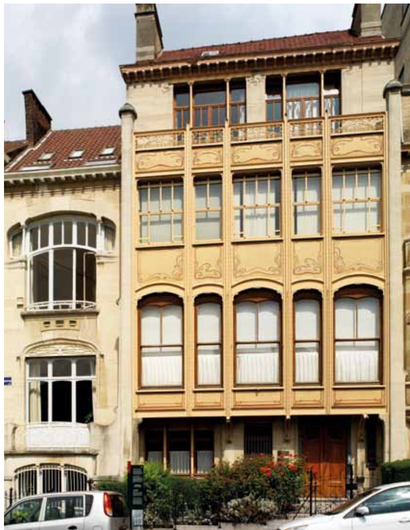
2 Victor Horta, Façade de l'hôtel Van Eetvelde, 4 avenue Palmerston à Bruxelles, 1895–97 (à gauche l'agrandissement de 1899), inscrit au Patrimoine mondial en 2000. La façade tout entière est construite comme un grand bow-window en métal dont les parties pleines sont décorées de mosaïques
