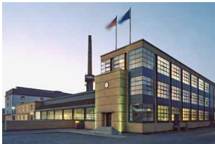
7 Walter Gropius, Fagus-Werk, Alfeld an der Leine, 1911 (Zustand 2011)
