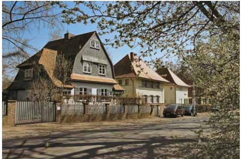
8 Ludwig Mahr, Georg Metzendorf und Arthur Wienkoop, Arbeiterhäuser (von links nach rechts), Hessische Landesausstellung, Darmstadt, 1908, transloziert an das Hofgut Oberfeld (Zustand 2009)
