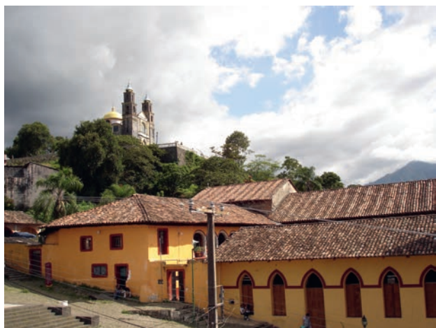
Fig. 13–14 Muros de piedra, cubiertas con tejados a dos y hasta cuatro aguas
