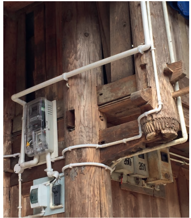
Fig. 4 (d) The improved electrical wiring
