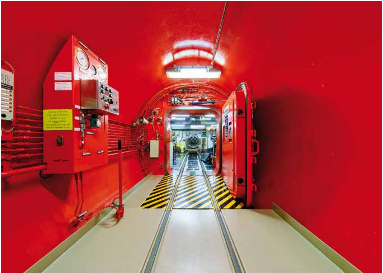
Abb. 3: Bernhard Ludewig: Kernkraftwerk Gundremmingen, Block B. Schleuse zum Steuerstab-Antriebsraum während der Revision. Juli 2015.
