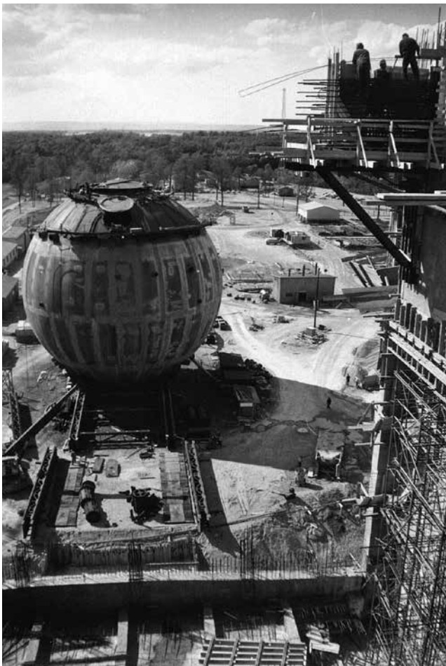
Abb. 1: Bau Kernkraftwerk Zwentendorf, 1973.
