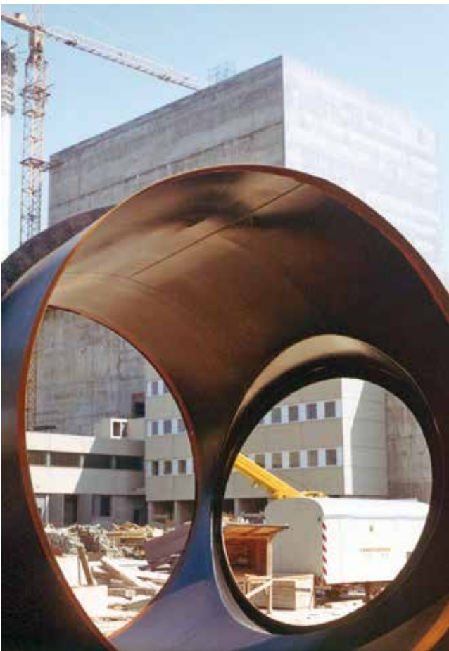
Abb. 3: Bau Kernkraftwerk Zwentendorf.
