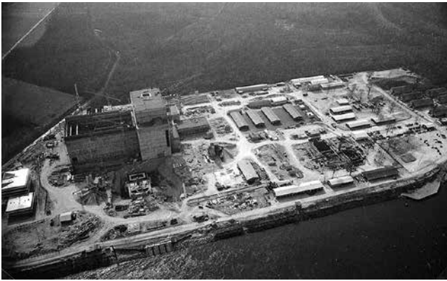
Abb. 2: Bau Kernkraftwerk Zwentendorf, 1974.
