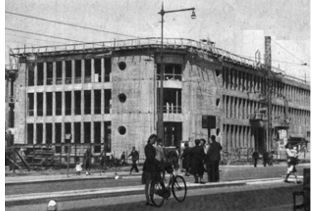
Abb. 7: Robaver am Coolingsingel, im Bau
