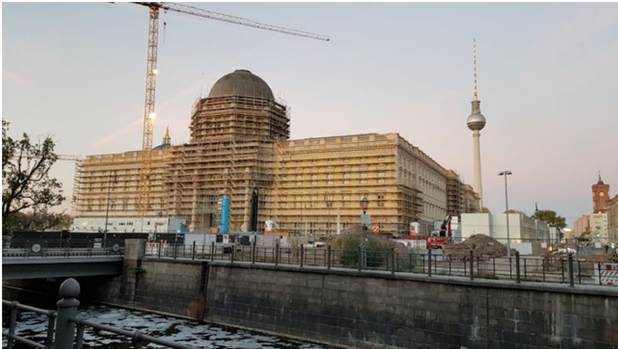
Abb. 17: Baufortschritt am neuen Berliner Schloss im Oktober 2018
