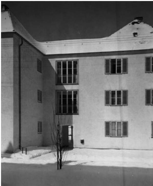
Abb. 7: Paul Schmitthenner, Südseite der „Kammbauten“ Auf der Steig, Siedlung Im Hallschlag, Stuttgart, Aufnahme nach Fertigstellung um 1930
