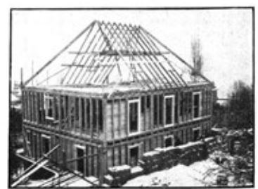
Abb. 41 bis 43 | Auf dem vorgeschriebenen Rüstboden werden die Rahmen des zweiten Stockes versetzt | In der Mitte: Der Winter setzt ein. Es wird weitergebaut | Rechts: Stand am dritten Tag. Der Dachstuhl ist aufgeschlagen. Die innere Schalung der Außenwände ist zu sehen.
