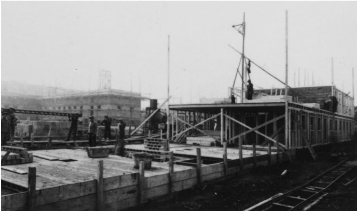
Abb. 5: Paul Schmitthenner, Geschosswohnungsbau in „Fabriziertem Fachwerk“, Siedlung Im Hallschlag, Stuttgart 1929/30
