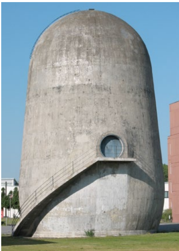
Abb. 10 a und 10 b: Denkmale der Luft- und Raumfahrt aus der Zwischenkriegszeit zählen zu den technischen Welterbepotentialen von Berlin. Neben den gewaltigen Stahlkonstruktionen des legendären Flughafens Tempelhof gelten die prägnanten Betonkonstruktionen der Versuchsanlagen der Luftfahrt in Adlershof-Johannisthal als international bedeutende Ingenieurbauwerke.
