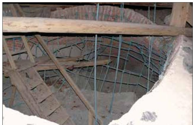
Abb. 6: Ursprüngliche Beleuchtungsöffnung im Gewölbe
