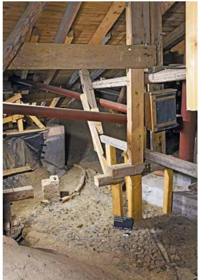
Abb. 7: Grottengewölbe über dem Hauptraum mit der nachträglichen Dachkonstruktion. In dem auf den Gewölbeoberseiten aufgetragenen Teerasphalt sind die zur Ableitung des Oberflächenwassers verlegten Drainagerohre und die Abdrücke der Sickerschicht aus groben Kieselsteinen zu erkennen.
