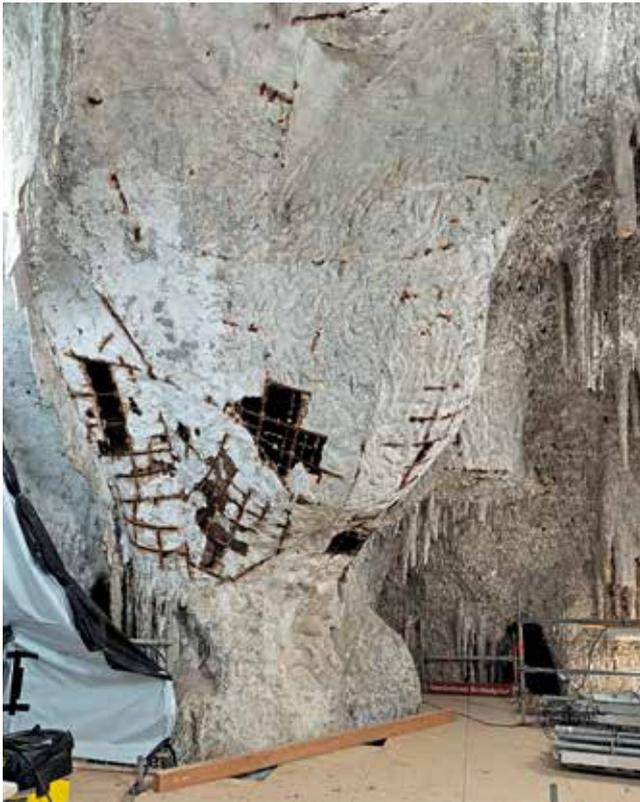
Abb. 8: Schäden an der Drahtputzschale
