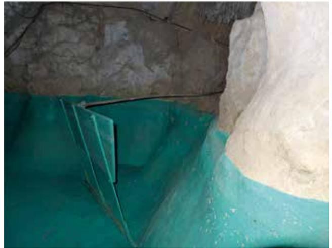
Abb. 11: Das „Wellenbrett“: ein Ruder, das mit Hilfe eines Hebels im Versorgungsgang händisch bewegt wurde
