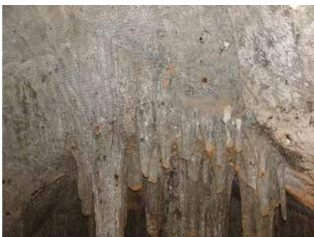
Abb. 9: Sandwichelement, Sicherung leicht geschädigter Putzbereiche durch ein eng anliegendes und kaum sichtbares Sechseckgeflecht aus Edelstahl. Das Sicherungselement wurde im Baulabor geprüft und als sicher eingestuft. Es wird zur zusätzlichen Sicherung der Führungslinie eingesetzt. Dass dieses System auch an den kompliziert geformten Teilen, z. B. Stalaktiten, gut funktioniert, zeigt dieses Foto.
