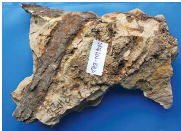
Abb. 1: Schlosspark Linderhof, Venusgrotte. Korrodiertes Flacheisen im Verbund mit Mörtel auf Romanzementbasis
