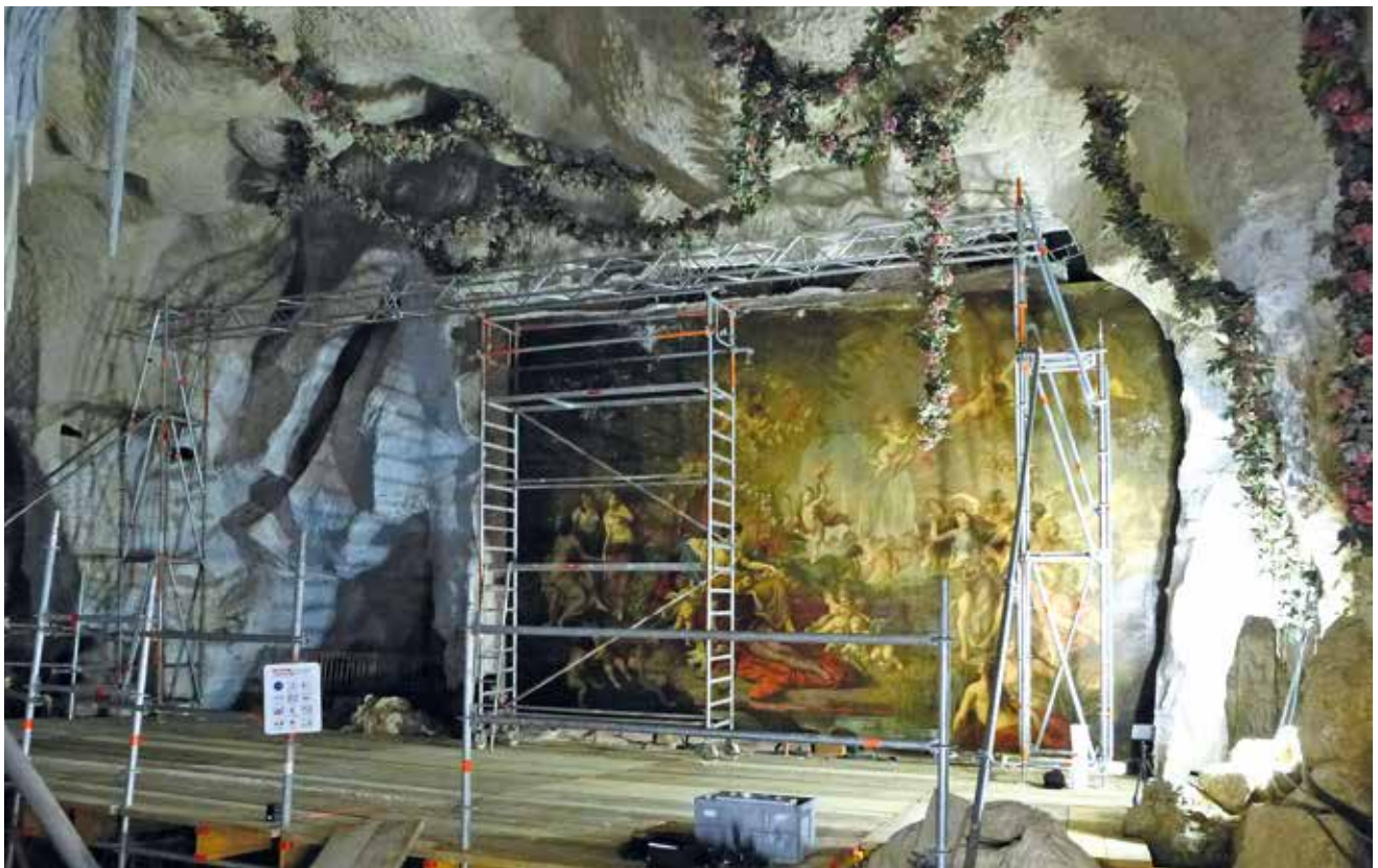
Abb. 6: Gerüsttürme und Arbeitsplattform
