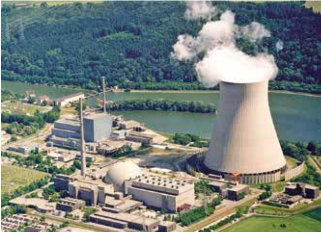
Abb. 10: Kernkraftwerk Isar in Ohu, Niederbayern, hinten Block 1 Siedewasserreaktor Baulinie 69, 1971–1979, vorne Block 2, Druckwasserreaktor Baulinie Konvoi, 1982–1988.
