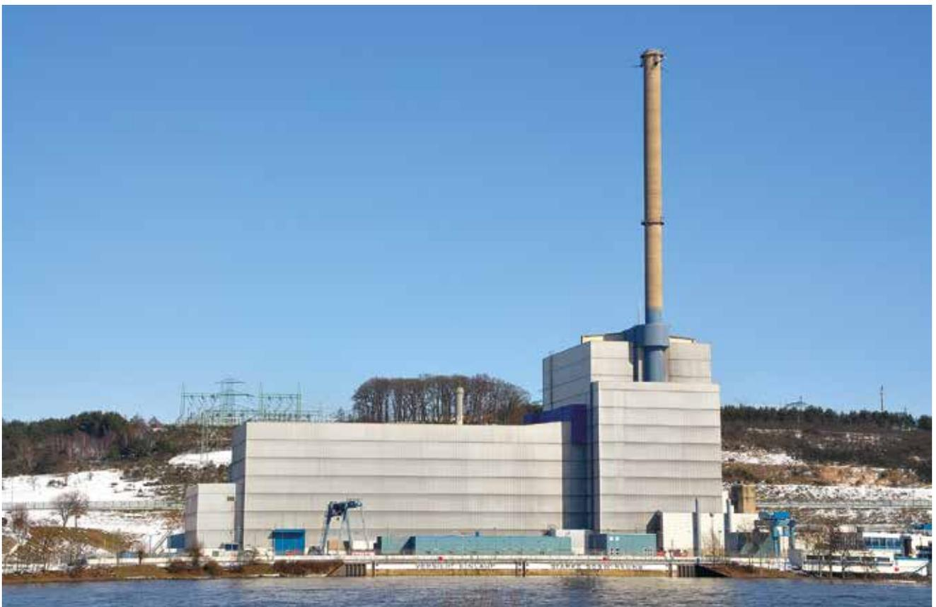
Abb. 7: Kernkraftwerk Krümmel 2010, Baulinie 69, Maschinenhaus und Reaktorgebäude sind in einem Baukörper vereint.
