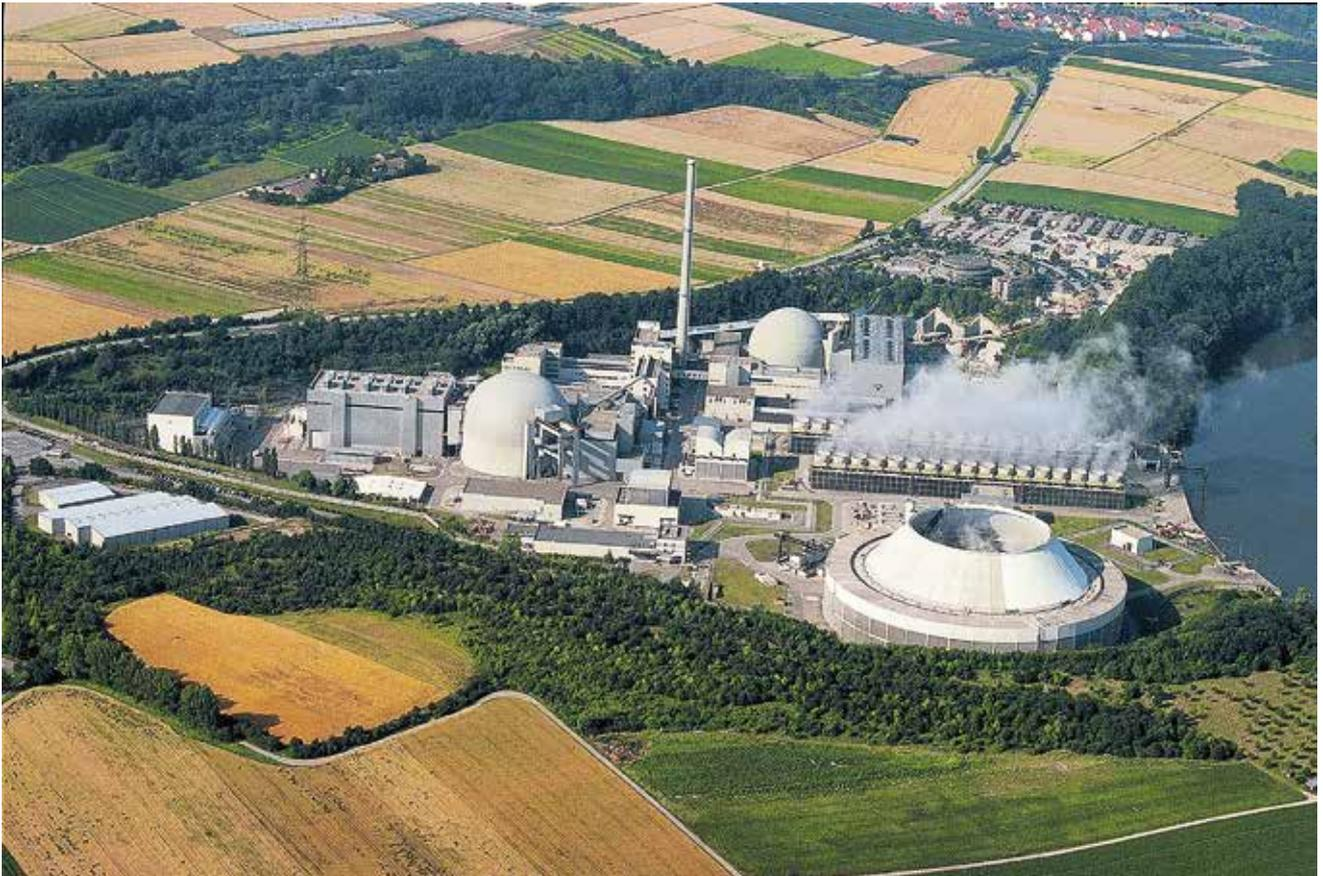
Abb. 6: Kernkraftwerk Neckarwestheim 2005, Hybridkühlturm unten, Zellenkühler oben (2012 abgebrochen).
