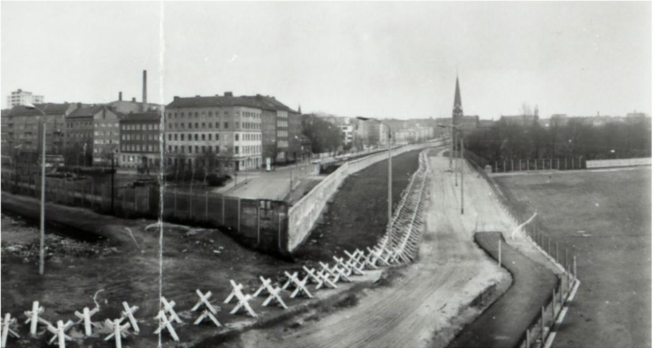
Abb. 12: Grenzstreifen an der Ecke Bernauer Straße/Gartenstraße/Nordbahnhof und Bergstraße vom 10. Mai 1970, in der Mitte zwei Reihen Fahrzeugsperrn auf Betonfundament, Kontrollstreifen und Postenweg der 2. Grenzausbauphase (1966–1979) (GBM, Bildarchiv, Bild-Nr. F-1091)
