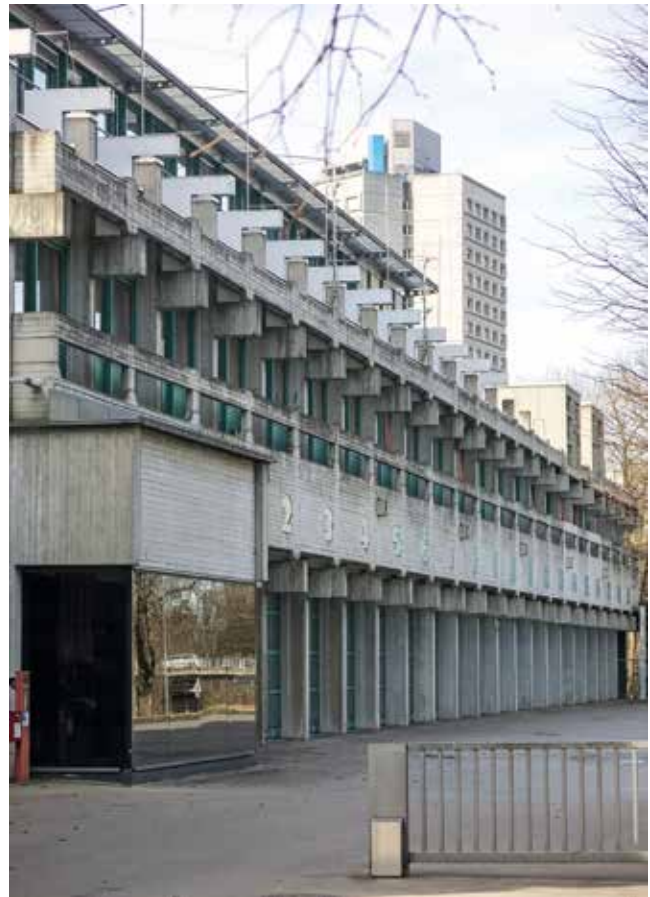
Abb. 2 Hauptfeuerwache, Berliner Allee, Erich C. Müller 1972–74, im Hintergrund Studentenwohnheim an der Lechbrücke, Richard Hohenner jun. und Hans Engel 1971–73, Foto: Olaf Gisbertz
