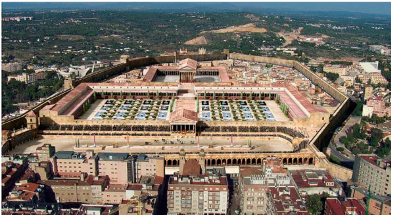
2 Superimposed images illustrating the survival of the Roman city in the fabric of the upper part of modern-day Tarragona Superposición de imágenes donde se puede apreciar la pervivencia de la ciudad romana en el trazado urbanístico actual de la zona alta de Tarragona
