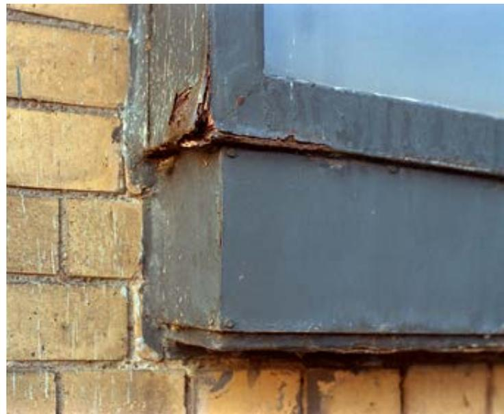
**4** Korrosionsschäden an den Fenstern des Hauptgebäudes, Zustand 1984
