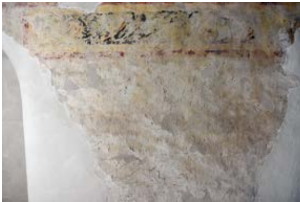
21 Wandmalereifries auf der Südwand im Erdgeschoss des Westwerks, Zustand 2020
