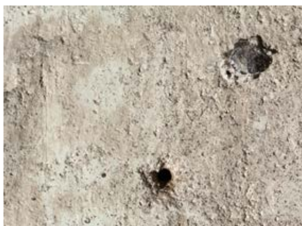
16 Handbehauener Eisennagel mit Stoffrest in situ sowie Eisenstiftloch, Westempore, Ostwand nach Süden, 2019
