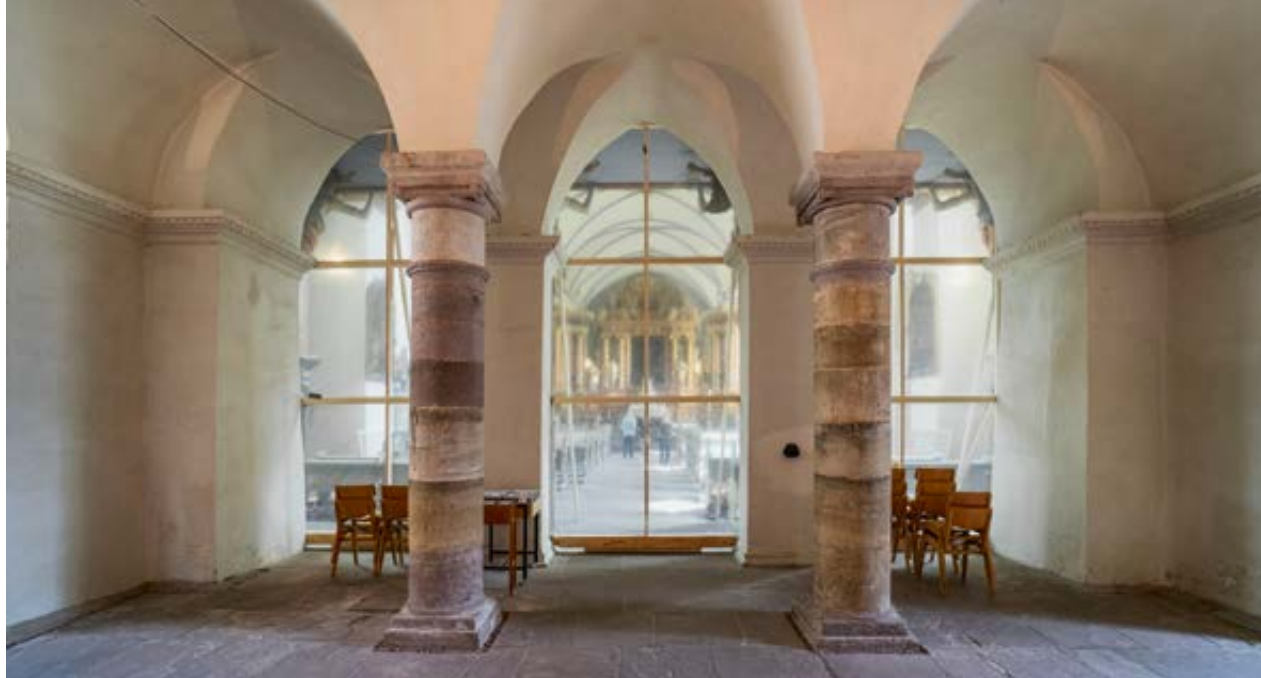
17 Einbau eines Eins-zu-eins-Modells der Glaswand im Erdgeschoss des Westwerks zur Überprüfung der klimatischen Auswirkungen, 2018
