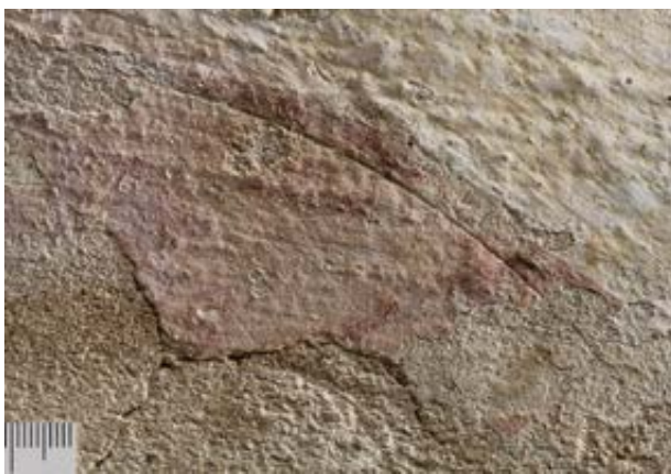
5 Zirkelschlag in den baufeuchten Putz für den Dreipass im Gewölbe des Westraums, 2019
