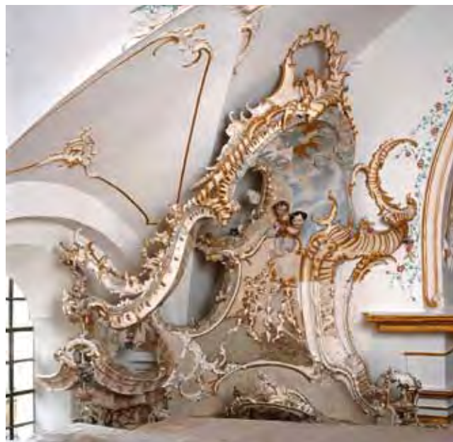
Abb. 3: Nördlicher Seitenaltar, Auszug nach Abschluss der Stuckreparatur mit Arbeitsprobe zur Farbfassung
