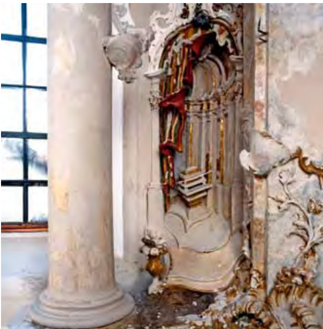
Abb. 14 und 15: Bundeslade vom nördlichen Seitenaltar und Zeltlager vom südlichen Seitenaltar nach Reparatur und Ergänzung der geschädigten Stucksubstanz
