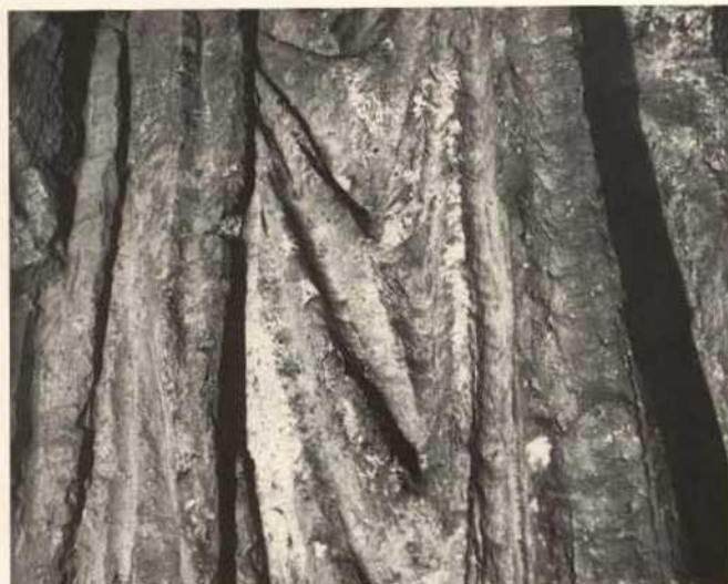
Abb. 196. Goslar, Vorhalle der ehem. Stiftskirche St. Simon und Juda, Giebelfeld, Detail der rechten Herrscherfigur. Dokumentation charakteristischer Schadensbilder: Stuckaufbrüche entlang vorstehender Gewandfalten.
