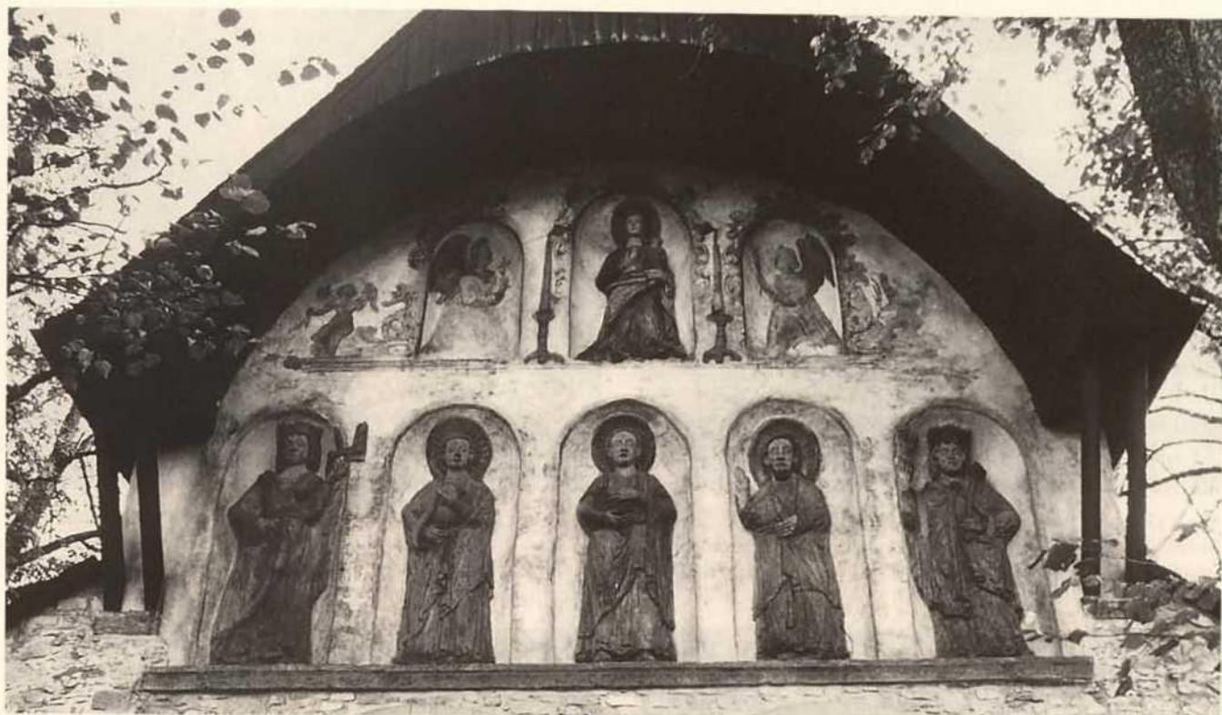
Abb. 191. Goslar, Vorhalle der ehem. Stiftskirche St. Simon und Juda, Giebelfeld. Zustand nach Abschluß der Restaurierungsarbeiten (1992).
