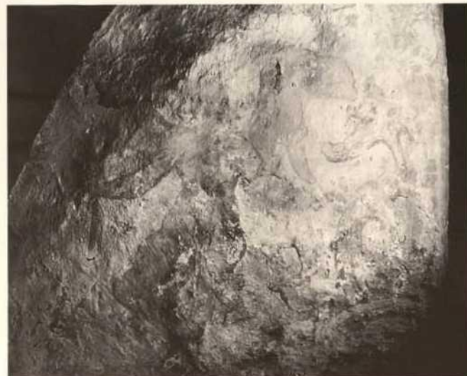
Abb. 197. Goslar, Vorhalle der ehem. Stiftskirche St. Simon und Juda, Giebelfeld, Detail: Vorzustandsdokumentation der barocken Wandmalerei im Streiflicht.
