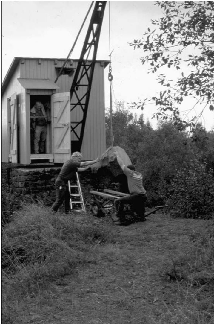
Abb. 6 Mayen (Kr. Mayen-Koblenz), Grubenfeld. Ein restaurierter Grubenkran wird auf seine Funktionalität geprüft.
