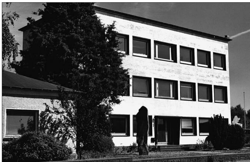
Abb. 14 Gebäude des Forschungsbereichs Vulkanologie, Archäologie und Technikgeschichte in Mayen.
