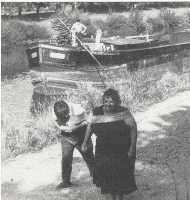
Abb. 22 Treidelszene von der Saar aus dem Jahr 1958. Mutter und Sohn »verholen« eine stählerne Péniche (kanaltauglicher Frachter); der Vater hält das Fahrzeug mit einer Spiere vom Ufer frei. (Foto: Wasser- und Schiffsamt Saarbrücken).
