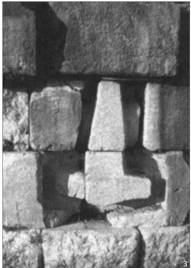
**Abb. 12** Nikopolis (Preveza, periféria Epirus/GR), Siegesdenkmal des Octavian. Strukturen Nr. #8 (1), #11 (2) und #13 (3) in der Terrassenmauer zum Einlassen eines erbeuteten Rammsporns. – (Nach Murray 2012, 41 Abb. 2, 6; 8, 11. 13).
