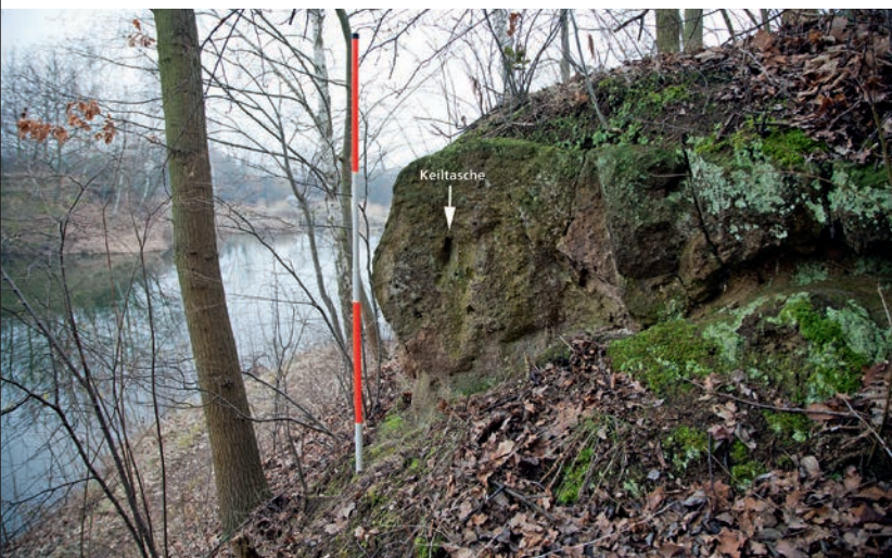
Stützpfiler eines römischen oder mittelalterlichen Tuffbergwerks in der Trassgrube Zerwas bei Kruft.
