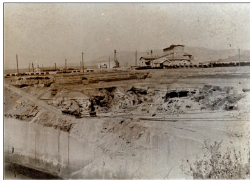
Tuffabbau der Trasswerke Meurin bei Kretz in den 1930er Jahren. Unter meterhohem Bims sind gleich mehrere römische Stollen im oberen Tuff angeschnitten; im Bildvordergrund hat der moderne Abbau schon den Grundwasserspiegel erreicht.
