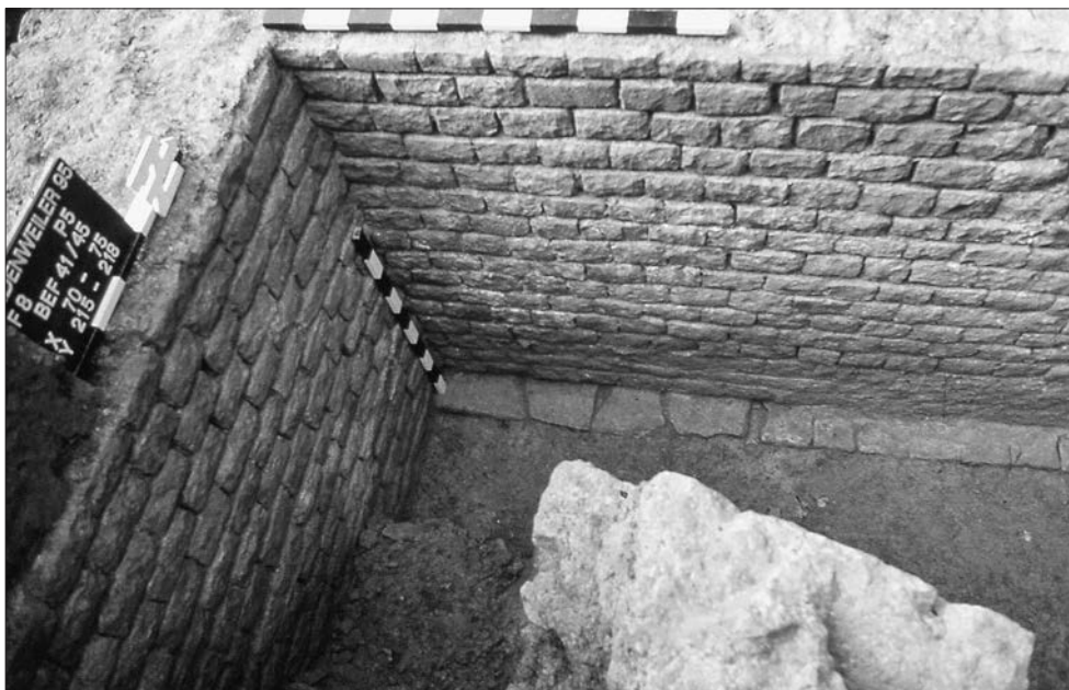
Abb. 8 Badenweiler: Blick auf die Innenseite der Nordmauer des Podiumssockels (Periode 3). Grabungsschnitt im Herbst 1995.
