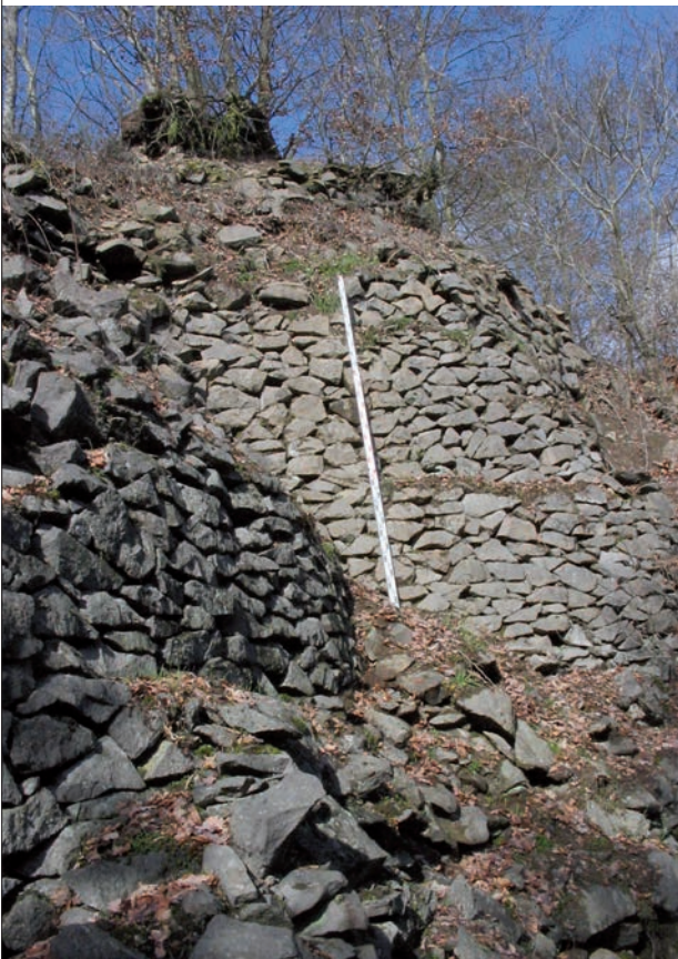
Mayener Grubenfeld. Mittelalterlicher Tagebau mit Stützmauern.
