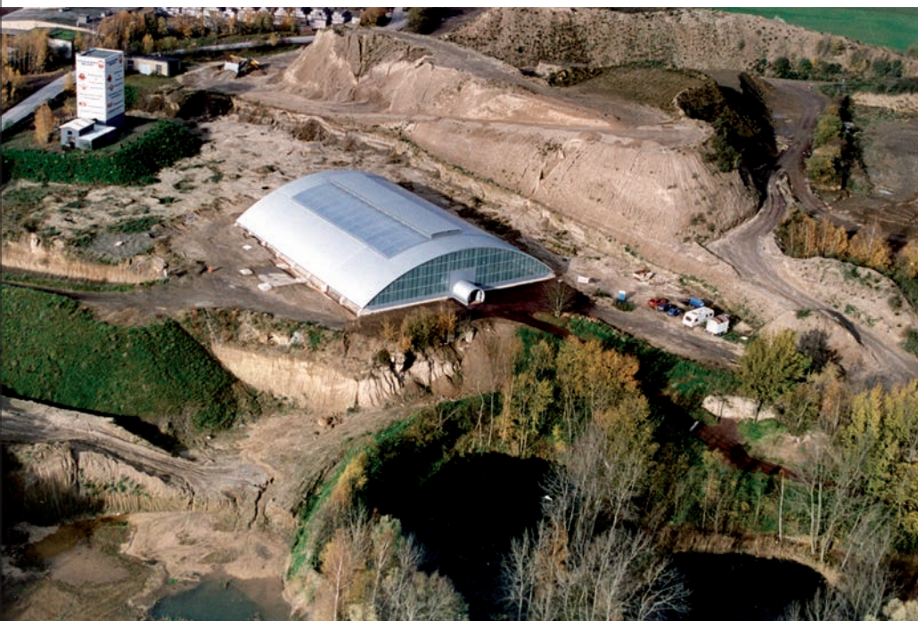
Inmitten des Firmengeländes der Trasswerke Meurin bei Kretz erhebt sich der moderne Schutzbau über dem Römerbergwerk Meurin.
