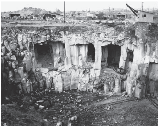
Vulkanpark – Vom neuzeitlichen Basaltabbau angeschnittene unterirdische Mühlsteinbrüche im Mayener Grubenfeld (Photo um 1930).
