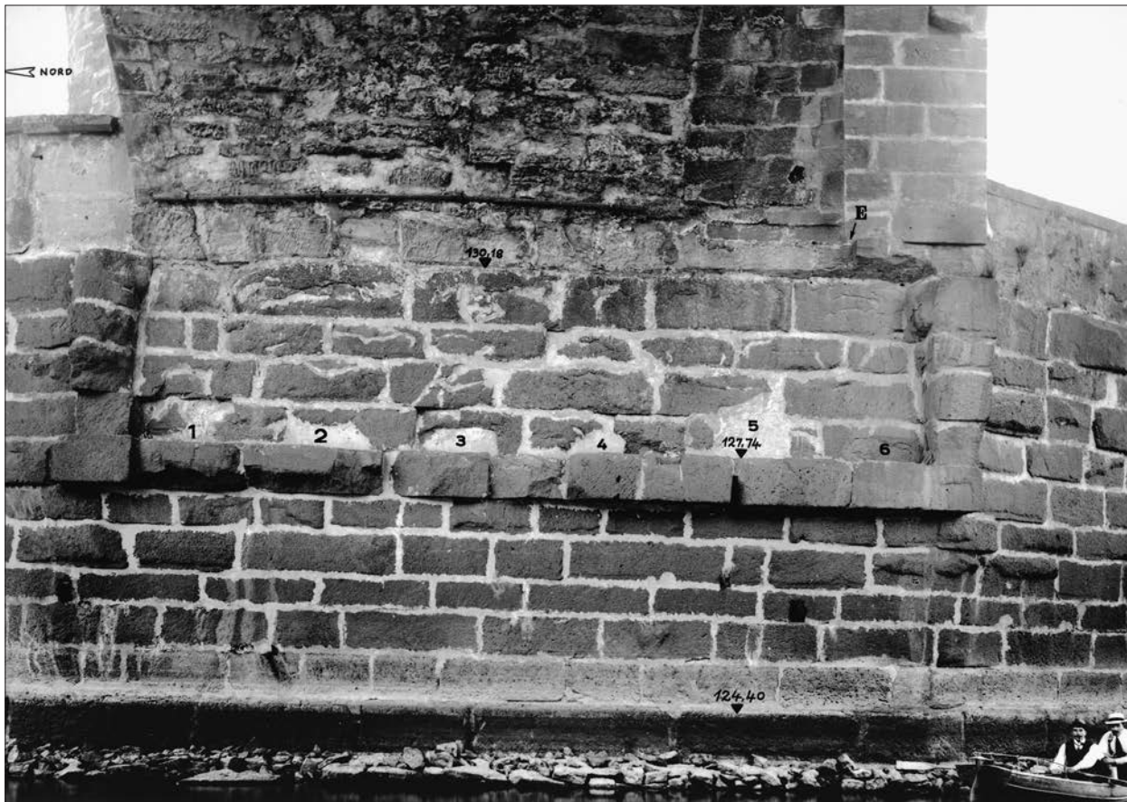
Abb. 8 Trierer Römerbrücke: Pfeiler V (3), Westseite. Kragleiste (▽ 127.74), darüber Einkerbungen 1-6 für die Aufnahme der Streben (teilweise verschlossen), Ansatz der seitlichen Blendleisten. Profilleiste E (vgl. Abb. 7). Mittelwasser = Wasserstand ▽ 124.40 (Sommer 1911). – (Foto Rheinisches Landesmuseum Trier, C 1100).
