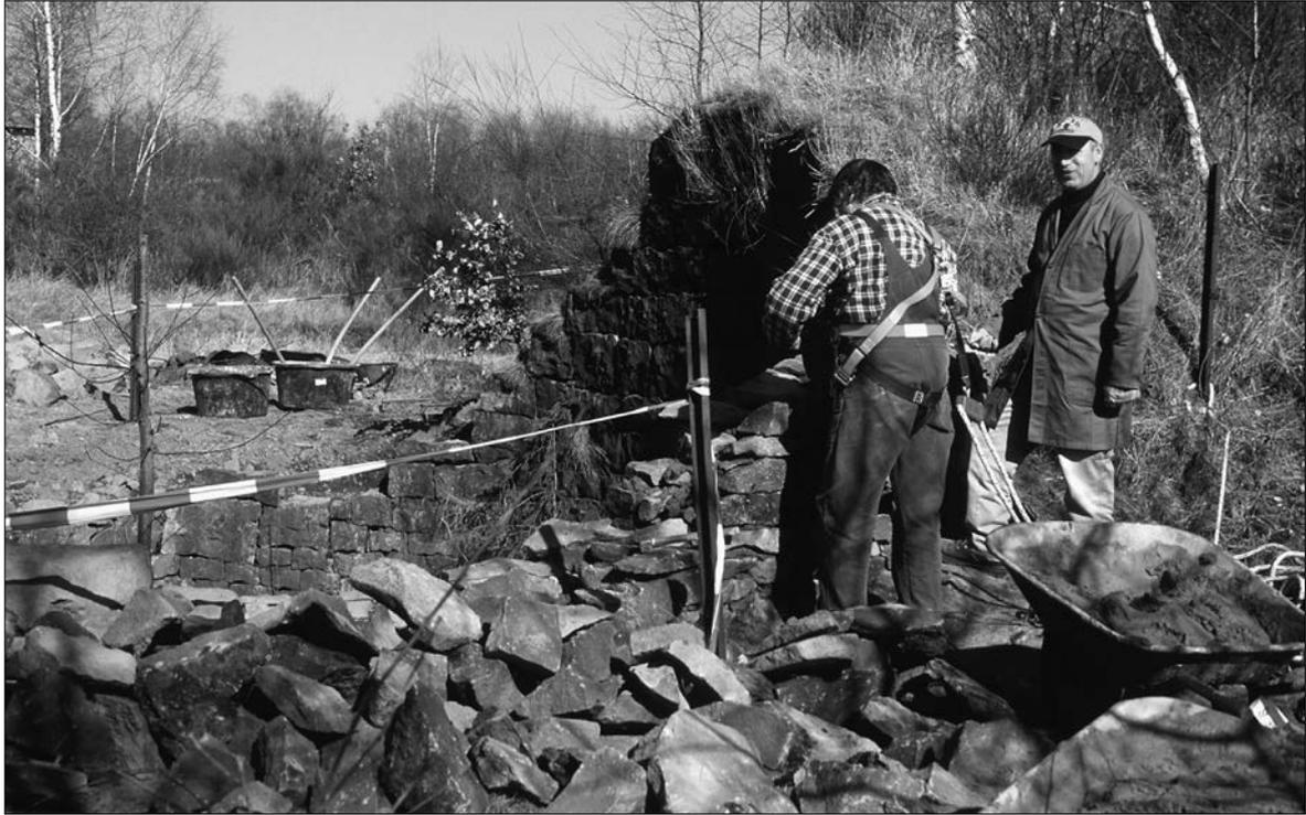
Abb. 1 Mayener Grubenfeld, Konservierung eines gemauerten Schachts in den unterirdischen Basaltlava-Abbau.
