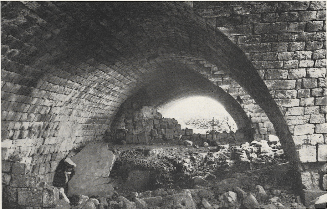
2 Blick in die Halle von Norden nach Süden.
