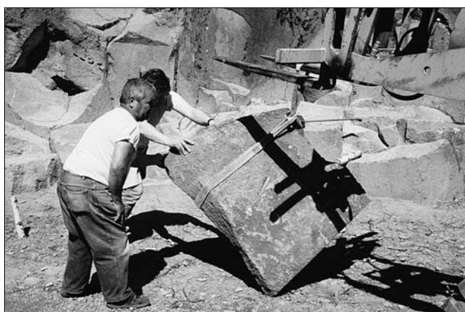
Abb. 16 Mayener Grubenfeld, »Silbersee«. Arbeiten für den archäologisch-vulkanologischen Wanderweg. Schwere Basaltlava-Säulen dienen als Träger für die Informationstafeln.
