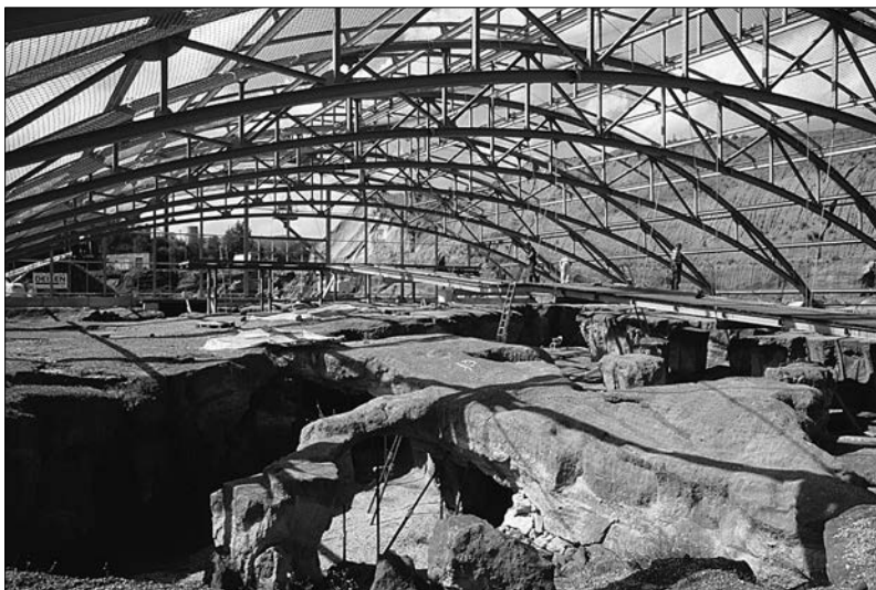
Abb. 4 Kretz, Tuffsteinbruch Meurin 2. Hinter sorgfältig aufgesetzten Trockenmauern wurde der Versatz gelagert. Ein System von schmalen, niedrigen Gängen führte einst durch den unterirdischen Steinbruch. →
