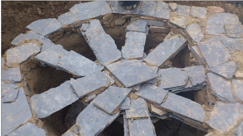
Abb. 7 Mayen, Versuchsofen 2014: Blick auf die Konstruktion der Tenne aus Schieferplatten während der Bauphase. – (Foto E. Hanning).
