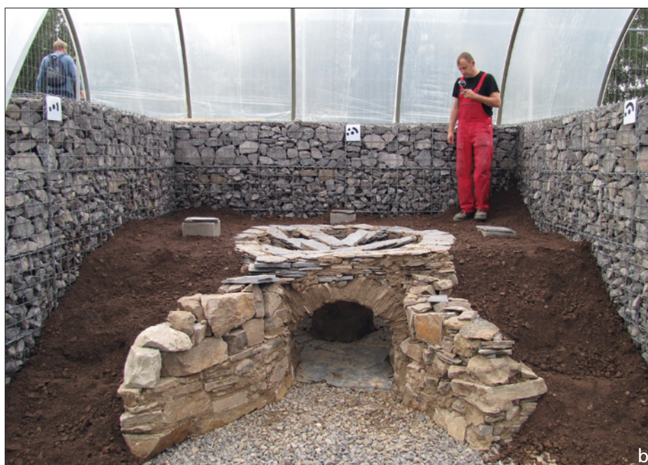
Abb. 5 Mayen, Versuchsofen 2014: a Zu Beginn des Ofenbaus wurde der Grundriss des Befundes im Innenraum des Gabionenwerkes mithilfe einer Papierschablone auf den Boden übertragen. – b Der Versuchsofen wurde – anders als der Originalbefund – nicht in einen bestehenden Hang eingetieft. Er wurde frei in einem Gabionenwerk errichtet und dann mit Sediment hinterfüllt. Auf diese Weise konnten auch Messschächte für die Thermolemente neben der Ofenwandung errichtet werden. – (a Foto B. Streubel, RGZM; b Foto RGZM).
