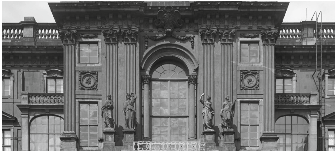
16 Berliner Schloss, Statuen am Risalit des Treppenhauses (Portal V) im Lustgartenflügel des Kleinen Schlosshofes, Aufnahme von 1944
