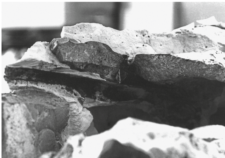
19, 20 Abtrag des in den Gips diffundierten Rostes am linken Armierungseisen
