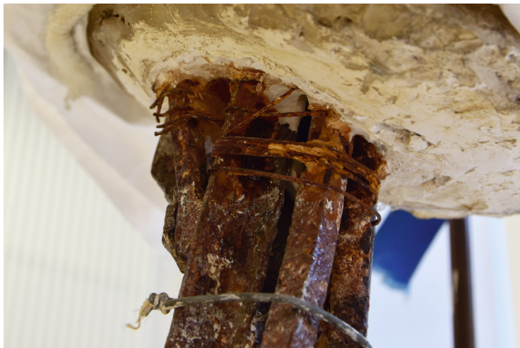
34 Abtrag von Rost durchdrungenen Gipspartien und Entfernen der Rödeldrähte
