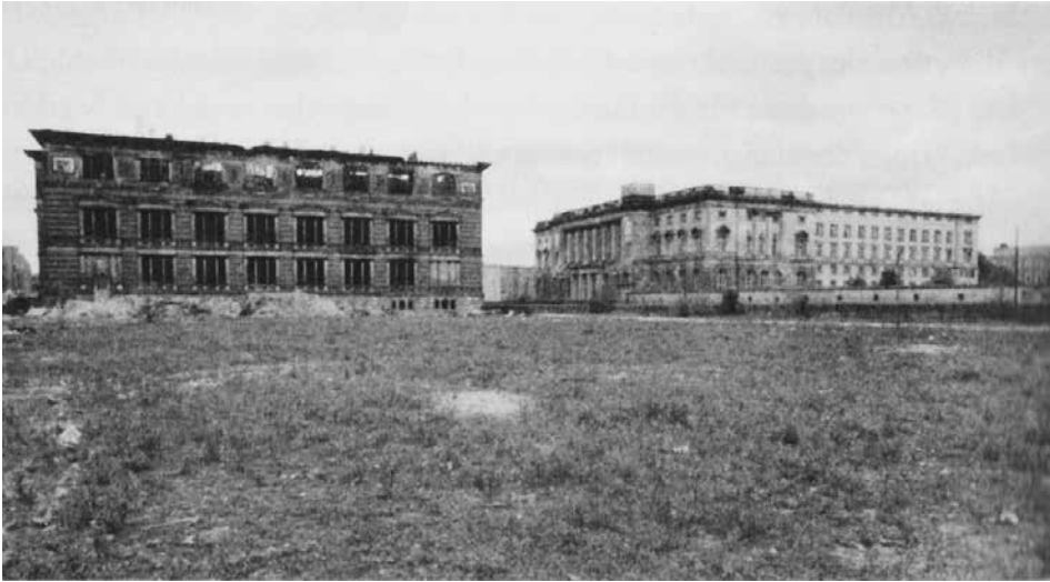
Abb. 2: Kriegersruine des Gropius-Baus nach der Enttrümmerung seiner bombenzerstörten Umgebung, um 1960 (568)
