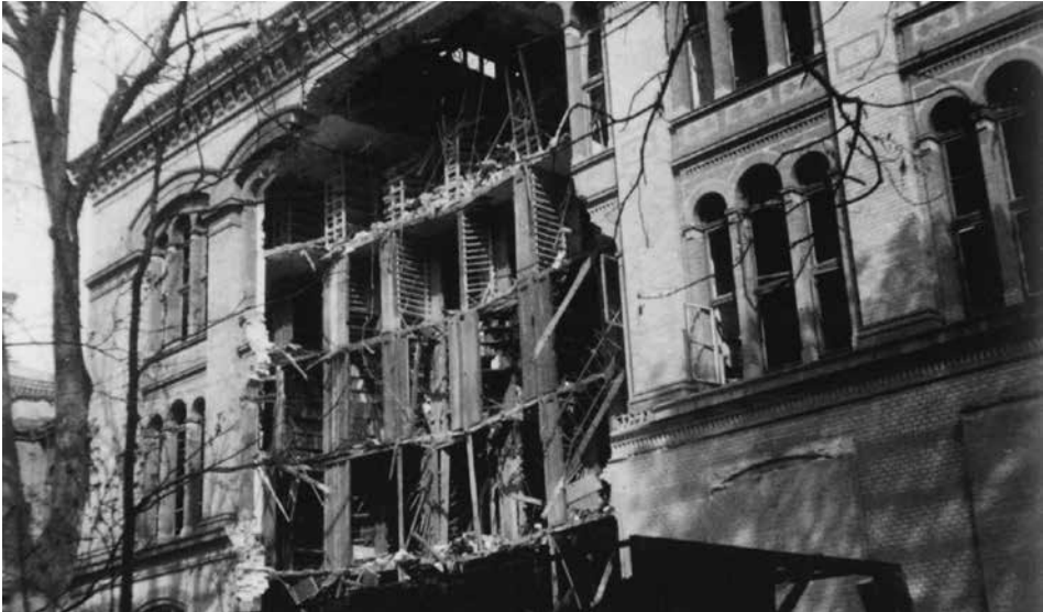
Abb. 2: Universitätsbibliothek Kiel, Ansicht von Südwesten (nach 1944). Man erkennt anhand der Kriegsschäden das eiserne Büchergestell des Magazins, das sich gewissermaßen als ‚Bau im Bau‘ zu erkennen gibt (128)
