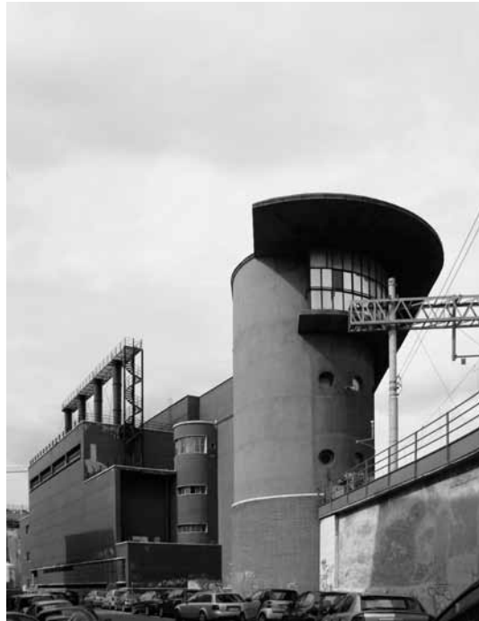
Abb. 1: Heizwerk und Wasserturm am Bahnhof Santa Maria Novella in Florenz, 1932–35 (Foto: Katrin Albrecht)
