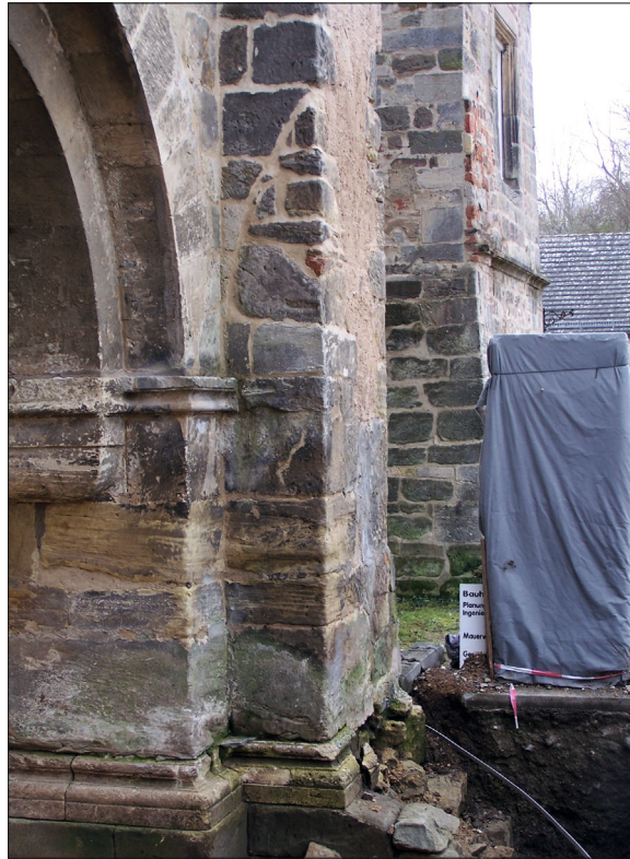
Abb. 37 Schloss Goseck, Burgenlandkreis. Der Ausbruch der Überwölbung eines Blindbogens im Abriss der Westwand zwischen den beiden Türmen der jüngsten Bauphase unmittelbar an der Nordwestecke des erhaltenen Südwestturmes von Osten.
