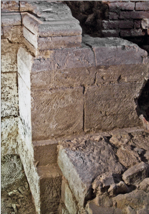
Abb. 24 Schloss Goseck, Burgenlandkreis. An seiner Nordostecke bildete der Neubau des Turmes in Phase II eine Vorlage nach Osten aus, welche in der Flucht der südlichen Mittelschiffsarkade lag. Diese Vorlage war mit dem typischen umlaufenden Sockelprofil versehen (oben). Nach Norden wurde die gesamte Situation beim Einbau eines modernen Schachtes abgebrochen, sodass unklar bleibt, welche Breite die Vorlage aufwies. Große Teile der Vorlage und ihres Sockelprofils wurden unmittelbar nach ihrer Errichtung bereits wieder durch das Mauerwerk verdeckt (im unteren Teil erkennbar), mit dem der ältere Turmtorso an den Turmneubau angefügt wurde.
