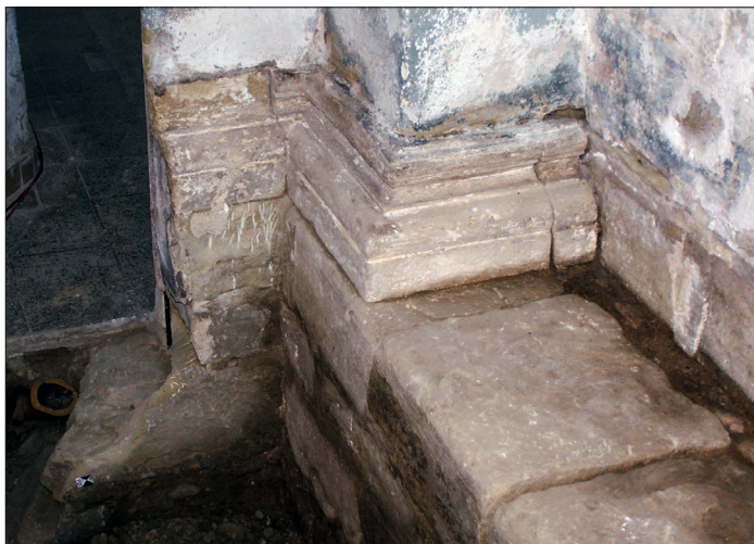
Abb. 36 Schloss Goseck, Burgenlandkreis. Der Anschluss des Sockelprofils an das Mauerwerk in der Südecke des Blendbogens vor der Westwand des Südwestturmes. Das Sockelprofil aus Kalkstein endet nach Westen gerade und stößt gegen den unteren Sandsteinquader der Rückwand. Eine identische Ausführung kann für das erhaltene Sockelprofil in der Verlängerung der Westwand des Turmes nach Norden angenommen werden.
