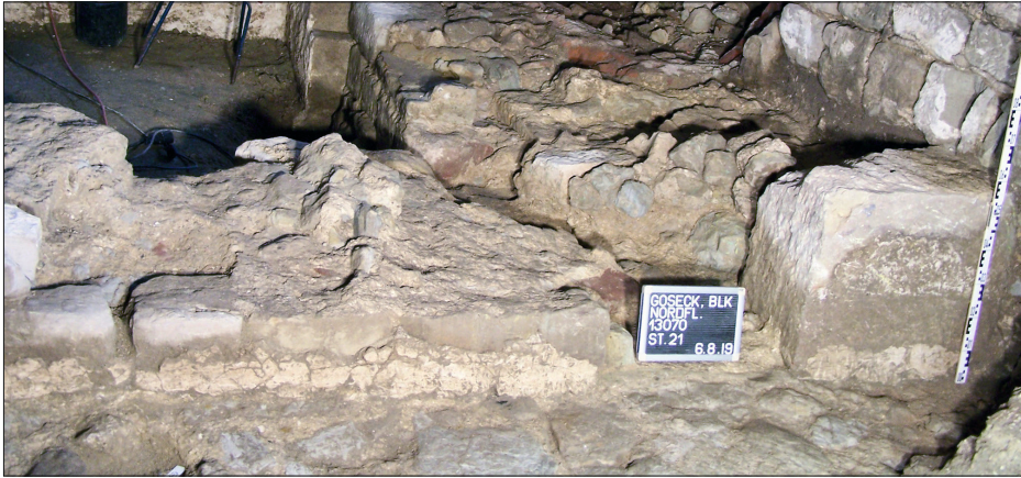
Abb. 15 Schloss Goseck, Burgenlandkreis. Die Ostansicht des erhaltenen Turmmauerwerks in ihrem nördlichen Abschnitt. Im Nordosten (rechter Bildrand) der Stein der Eckquaderung. Fast in ganzer Länge der Mauer konnte ein schmaler Streifen Verputz mit weißer Kalktünche dokumentiert werden, welcher sich direkt über dem vorkragenden Fundament befand. Der Eckquader wies ebenfalls diese Putzreste auf.
