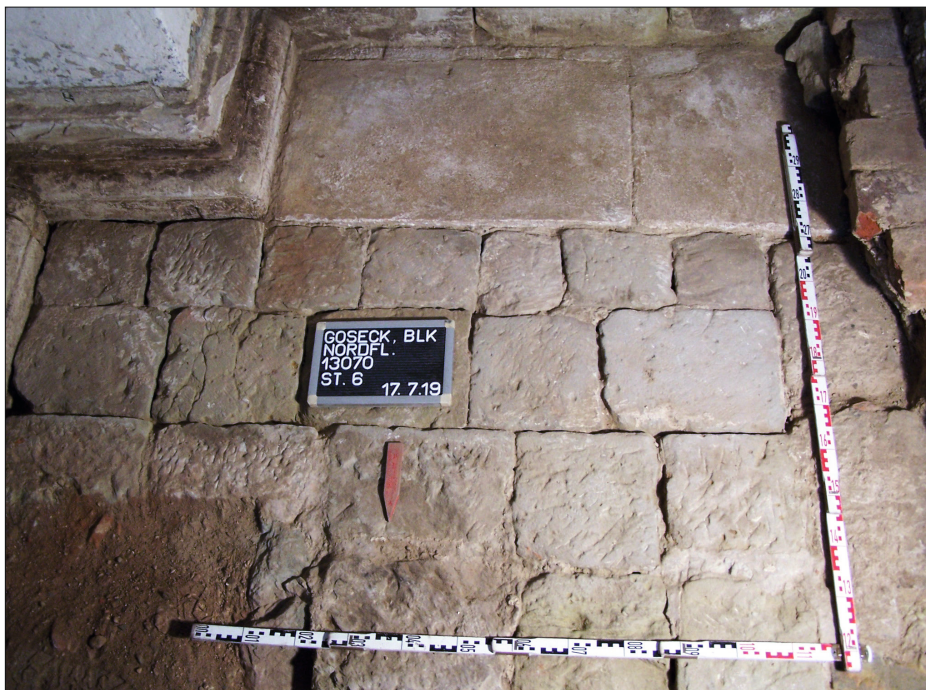
Abb. 23 Schloss Goseck, Burgenlandkreis. Der Belag aus Gipsestrichplatten (hinten) auf dem Sockel des südlichen Blendbogens des Südwestturmes. Davor der neuzeitliche Fußboden des Erdgeschossraumes aus Sandsteinplatten. Rechts der überwiegend aus Ziegelsteinen errichtete Einbau der Treppenwanne des neuzeitlichen Südzugangs.
