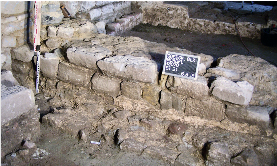
Abb. 16 Schloss Goseck, Burgenlandkreis. Der südliche Abschnitt der Ostansicht des älteren Turmmauerwerks. Erkennbar ist eine Ausführung der Ostseite des aufgehenden Mauerwerks aus gequadrten Sandsteinen in lageweisem Versatz. Auch hier sind größere Partien von Verputz direkt über der Fundamentoberkante erhalten.
