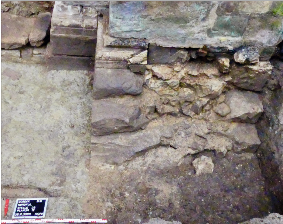
Abb. 26 Schloss Goseck, Burgenlandkreis. Der Abbruch der Kirchenwestwand der zweiten Bauphase unmittelbar an der Nordwestecke des erhaltenen Südwestturmes. Im oberen Bereich der senkrechte Abschluss des Sockelprofils. Im Abbruch der Wand unmittelbar westlich des erhaltenen Profilsteins ist ein eingebundener, abgeschlagener Werkstein erkennbar, der nach Norden aus der Wand herausragte und die Innenkante der Wand hinter einem Blindbogen markiert. In Höhe der Unterkante des zweiten Steines unter dem Sockelprofil konnte – horizontal durchlaufend – eine signifikante Änderung im verwendeten Mörtel beobachtet werden, die vielleicht auf eine kurzzeitige Unterbrechung im Bauablauf hinweist.
