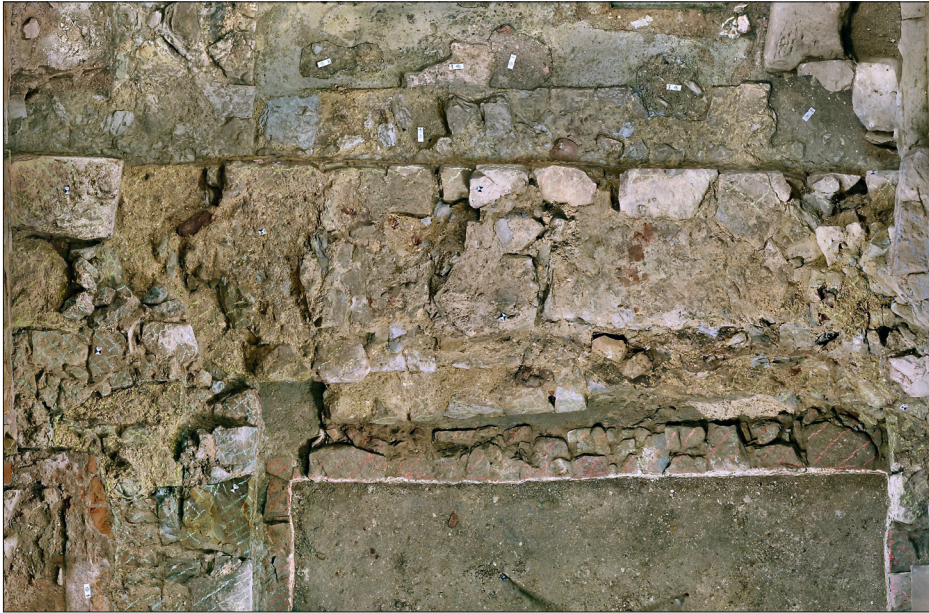
Abb. 17 Schloss Goseck, Burgenlandkreis. Das Mauerwerk Bef. 10 in der Draufsicht mit Blick nach Osten (oberer Bildrand). Zu erkennen ist die weit vorkragende Fundamentierung auf beiden Seiten. Die östliche Mauerflucht verläuft sehr exakt und die Außenschale wurde hier aus meist größeren Sandsteinen errichtet. Ganz links befindet sich der große Quader, der die Nordostecke des Mauerverlaufs markiert. Bei dem Quader handelt es sich um den Rest einer Eckquaderung an der Außenecke des Turmes, die offensichtlich frei im Kirchenraum stand. Im Gegensatz dazu steht der unregelmäßige und kaum aus größeren Steinen ausgeführte Kantenverlauf im Westen, also im Turminnenraum. Vor der Mauer Bef. 10 – den erhaltenen Turminnenraum ganz einnehmend – befand sich eine neuzeitliche Kalkgrube, die auch unter Zuhilfenahme von Ziegelmateriale errichtet wurde und mit deren Bau der gesamte Rest des Turminnenraumes seiner Schichtenfolge beraubt wurde. In die Südwand der Grube wurde ein geringer Rest Mauerwerk der Turmsüdwand integriert, sodass eine relativ präzise Rekonstruktion der lichten Weite des Turmuntergeschosses in Nord-Süd-Richtung möglich ist.
