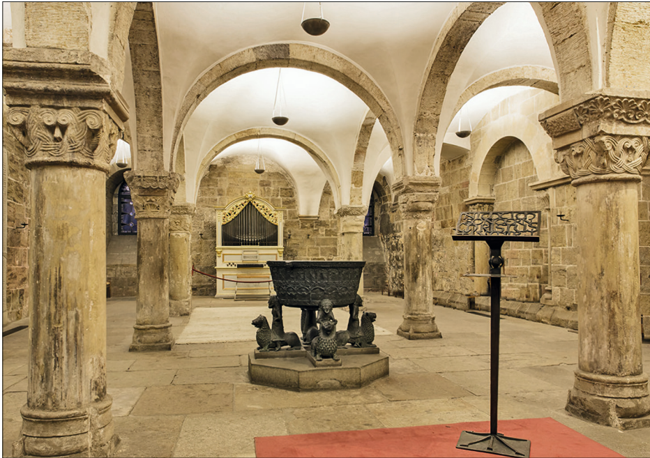
Abb. 33 Blick von Südosten in die Westkrypta des Bremer Domes. Die Nordwand ist mit einem Blendbogen und einem Werksteinsockel gegliedert. Beide Elemente fehlen an der Südwand.
