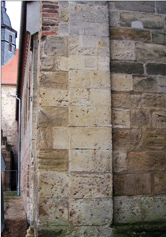
Abb. 38 Die Ansicht des Abbruchs der Westwand der Gosecker Klosterkirche unmittelbar im Anschluss an den Südwestturm mit Blick nach Osten. Hier ist in der fraglichen Höhe keinerlei Ansatz einer bogenförmigen Maueröffnung zu erkennen. Das gequaderte Sichtmauerwerk ist in ungestörten horizontalen Lagen erhalten, die an der Abrisskante mehr oder weniger sorgfältig abgearbeitet worden sind.
