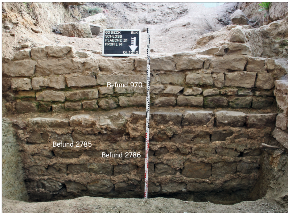
Abb. 10 Schloss Goseck, Burgenlandkreis. Blick von Norden auf die Fundamentierung der Nordwand des nördlichen Seitenschiffes (Grabung Universität Halle). Das Mauerwerk gehört unzweifelhaft zum Gründungsbau (Phase Ia) und verdeutlicht den lagenweisen Aufbau aus handlichen Quadern, wie er auch an den Fundamenten Bef. 35 (Abb. 6) und Bef. 87 (Abb. 9) zu beobachten ist.
