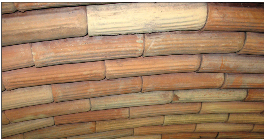
Abb. 38 Kaufering, Lkr. Landsberg am Lech. KZ-Außenlager Kaufering VII. Blick in ein rekonstruiertes Röhrengewölbe. Zustand 2016.
