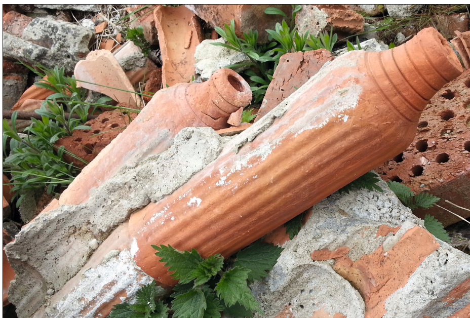
Abb. 39 Kaufering, Lkr. Landsberg am Lech. KZ-Außenlager Kaufering VII. Fundsituation von vermauerten Wölbröhren an einer verfallenen Baracke.
