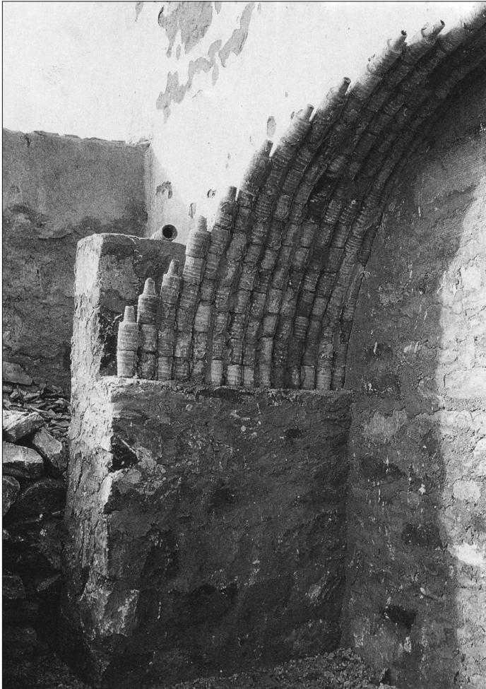
Abb. 7 Experimentelle Rekonstruktion eines Tonnengewölbes während der deutsch-tunesischen Ausgrabungen 1973 in Chemtou, Tunesien. Zu sehen sind die Bogensegmente des linken Auflagers im Aufbau.
