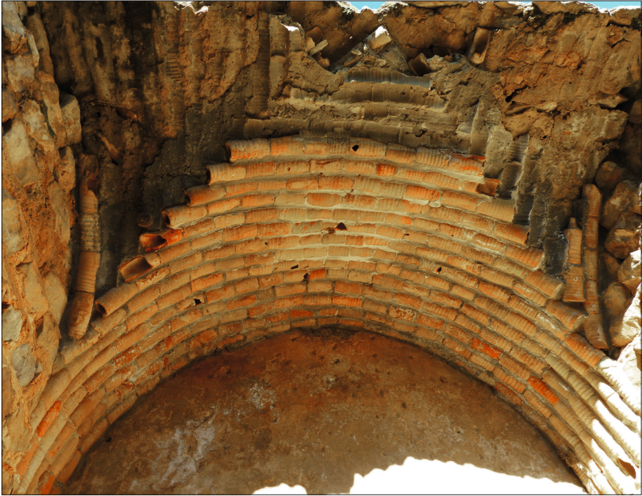
Abb. 21 1976 aus originalen Röhrenfunden neu errichtetes, vom Zahn der Zeit in Mitleidenschaft gezogenes Kreuzgratgewölbe in der unterirdischen Etage eines innerstädtischen Peristyl-Hauses in der römischen Stadt Bulla Regia, dem heutigen Hammam Daradji, Tunesien (freundl. Hinweis S. Storz, Dresden).
