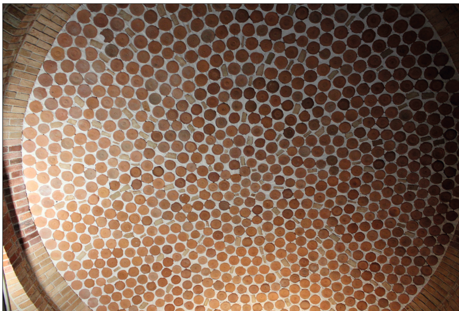
Abb. 32 Berlin, Neues Museum. Rekonstruierte flache Pendantkuppel aus keramischen Kapseln im Majolikasaal des 2. Obergeschosses. Detail der Auszickung von Zwischenräumen mit Ziegelstücken. Zustand 2018.
