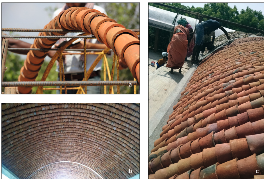
Abb. 41a–c a Der Baubeginn eines neuen Röhrengewölbes mit dem ersten gelegten Bogen, darunter ein unterstützendes Lehrgerüst aus Eisenstangen (Auroville, Tamil Nadu, Indien, 2013). b Das neue Gewölbe von innen. Das Lehrgerüst ist entfernt, die Gewölbefläche kann jetzt mit einer Mörtelschicht verkleidet werden oder frei bleiben (Bilaspur, Chhattisgarh, Indien, 2016). c Das Gewölbe aus Röhrenbögen mit abwechselnder Legerichtung ist fertig, im Hintergrund beginnt die Bedeckung mit einer Mörtelschicht (Bilaspur, Chhattisgarh, Indien, 2016)
