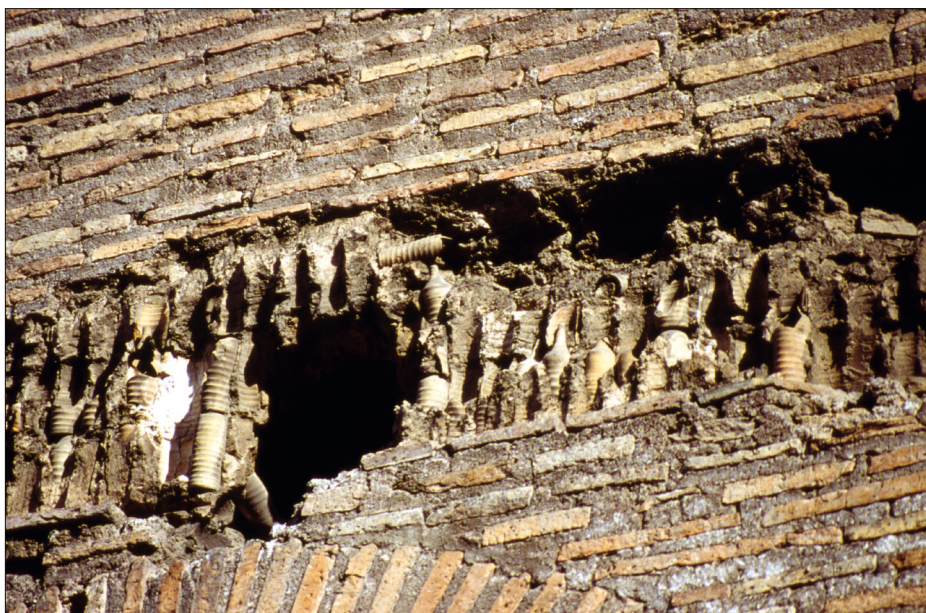
Abb. 25 Santo Stefano Rotondo in Rom, Italien. Westlicher Diagonalsektor mit Ausbruchsfries des abgeschlagenen Röhrengewölbes. Detail des Gewölbeansatzes mit Röhren und Gipsmörtelbett. Zustand 1996.
