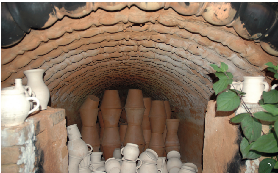
Abb. 48a–b Stoob, Österreich. 2006 im Gebrauch befindlicher Keramikbrennofen mit innen unverkleidetem Topfgewölbe mit durchgehenden, in wechselseitiger Steckrichtung hintereinander gesetzten Topfrehien. Pro Bogen wurden ca. 15 Gefäße verbaut.
