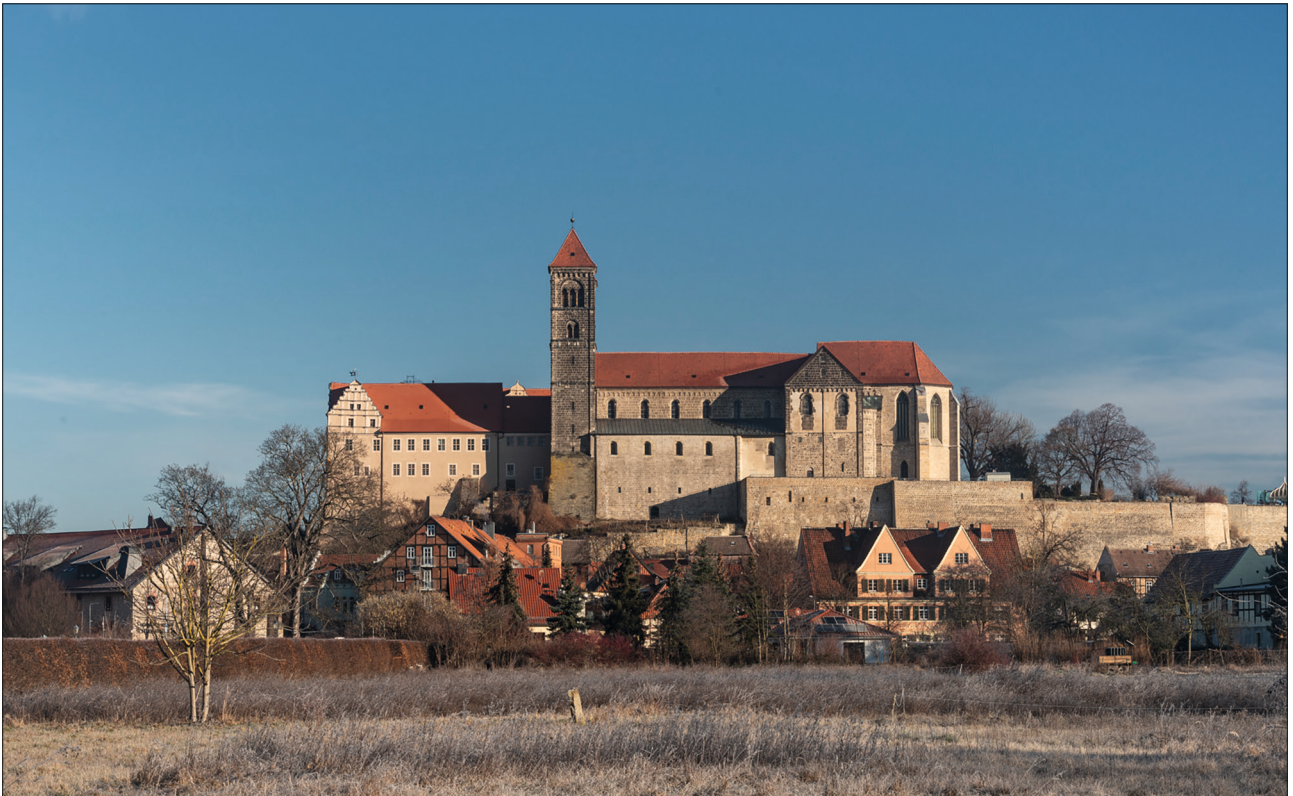
Abb. 3 Der Stiftsberg mit der St. Servatius-Kirche in Quedlinburg. Blick vom Abteigarten in Richtung Norden.
