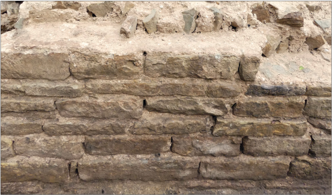
Abb. 8 Kloster Posa bei Zeitz, Burgenlandkreis. Detailansicht der erhaltenen Mauerschale auf der Innenseite der Nordwand des Turmes.
