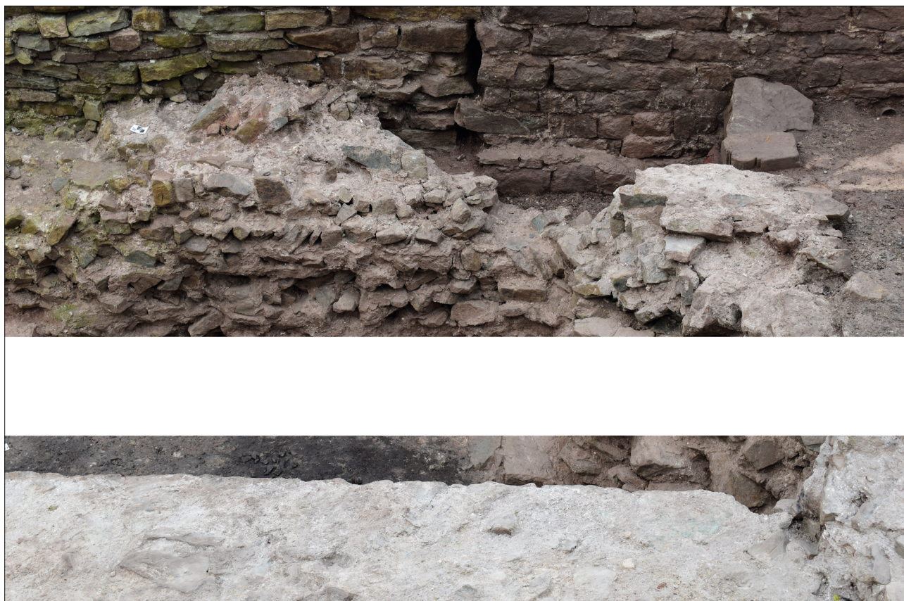
Abb. 9 Kloster Posa bei Zeitz, Burgenlandkreis. An den Mauerwerkspartien, an welchen die Mauerschale fehlt, ist der lagenweise Aufbau des Mauerwerks gut erkennbar. Die Steine wurden erst nach dem Aufschichten mit Mörtel vergossen, wodurch zahlreiche kleinere Hohlräume entstanden.
