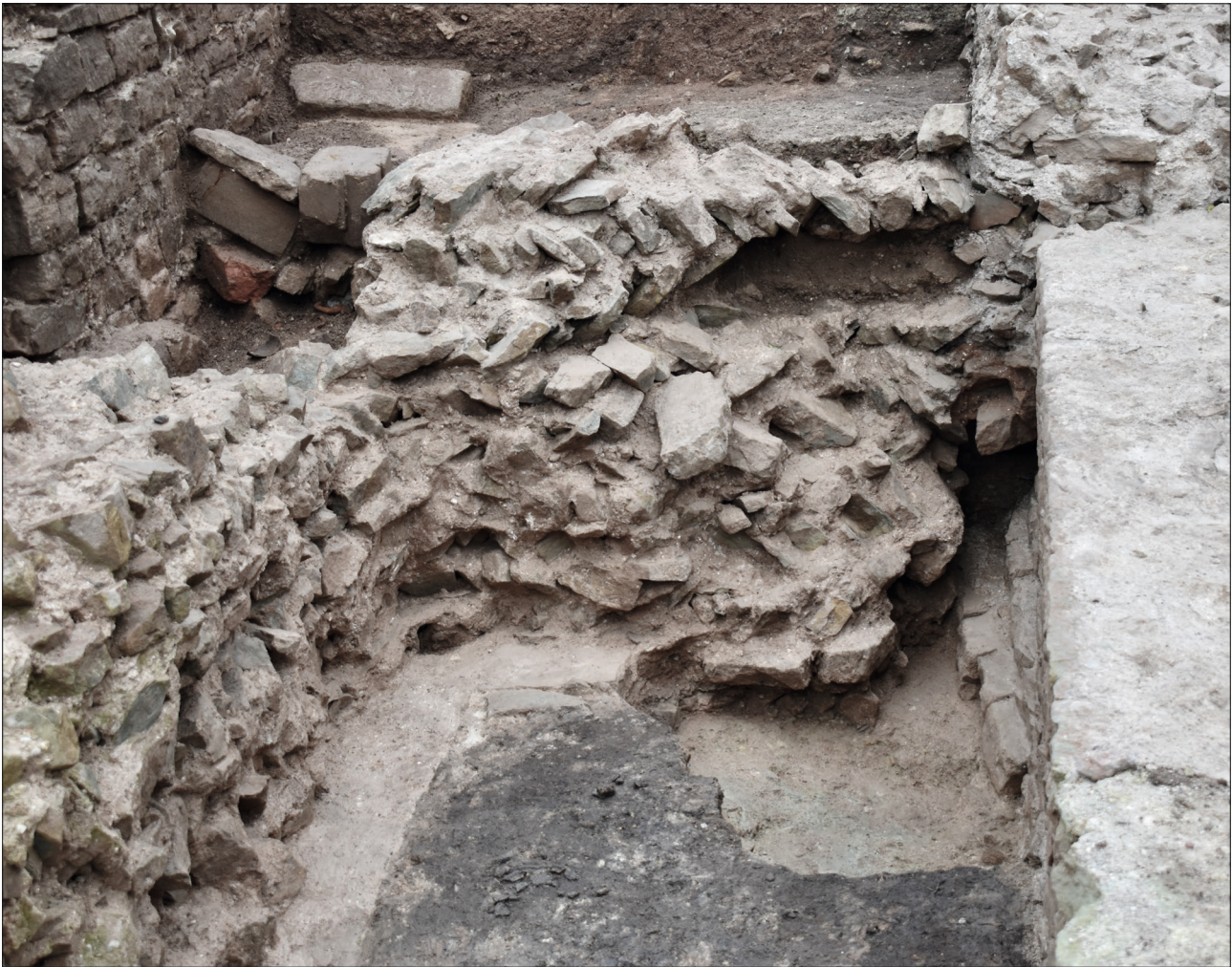
Abb. 10 Kloster Posa bei Zeitz, Burgenlandkreis. Blick vom Innenraum auf die Ostwand des Turmes. Die Mauerschale wurde hier fast vollständig abgebrochen. Im Vordergrund der Fußboden aus der letzten Nutzungsphase. Rechts (Süden) das Mauerwerk der gotischen Kreuzgangrückwand. Im oberen Bereich des Turmmauerwerks ist eine größere Fehlstelle zu erkennen, die wahrscheinlich auf einen ehemals hier verbauten Holzbalken zurückgeht.
