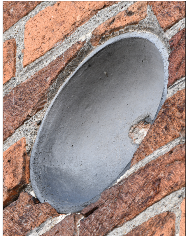
Abb. 10 Stiftskirche Jerichow. Analog zur südlichen Schale verfügt auch die nördlich angebrachte über einen stark gewölbten Boden.
