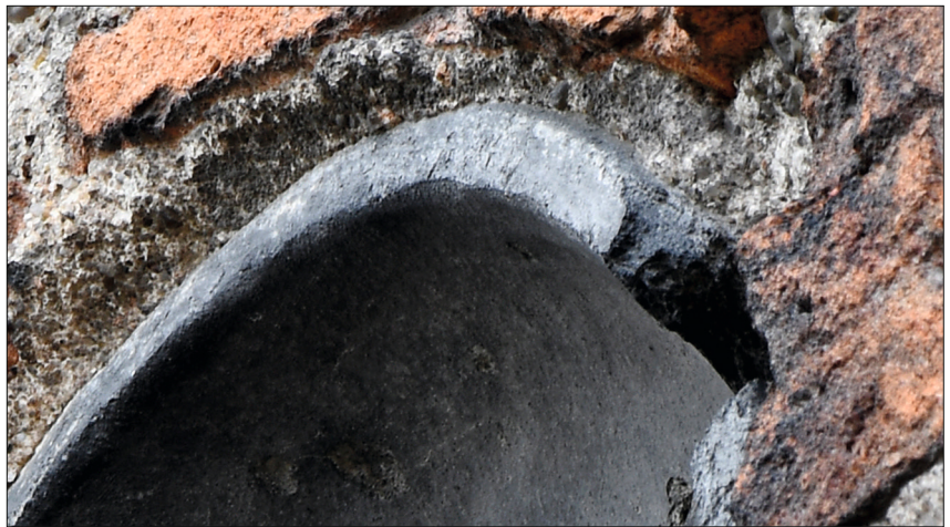
Abb. 12 Stiftskirche Jerichow. Die Bruchkante an der Mündung der nördlichen Schale zeigt das kantige Profil im Mündungsbereich ohne explizite Ausmodellierung.
