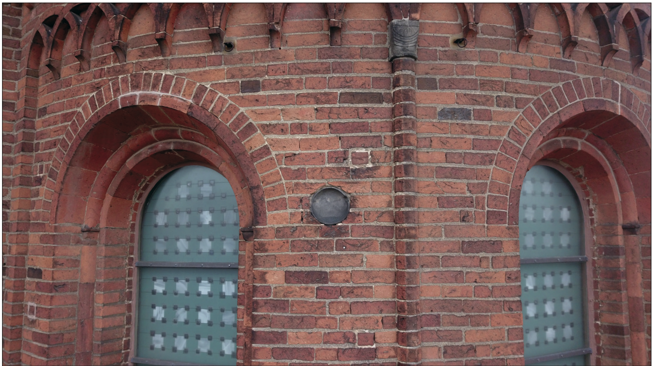
Abb. 6 Stiftskirche Jerichow. Drohnenaufnahme der Anbringung der südlichen Schale (Bacino) aus einheitlich reduzierend gebrannter Irdenware zwischen den Fenstern.
